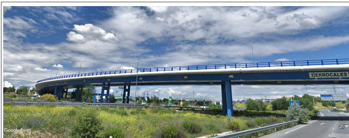
Figura 2.30: puente de Berrocales atravesando aproximadamente 300 metros de autopista. Fuente: Google StreetView.
